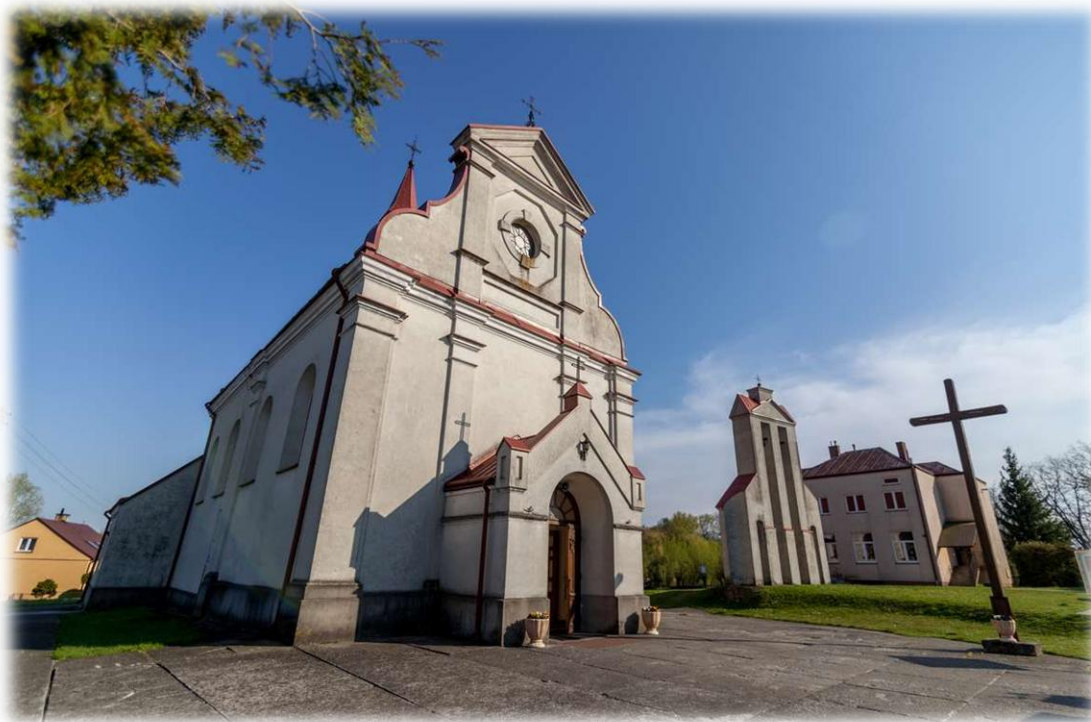
Zdjęcie 18 Zespół kościoła rzymskokatolickiego pw. Św. Mikołaja w Rudolowicach
